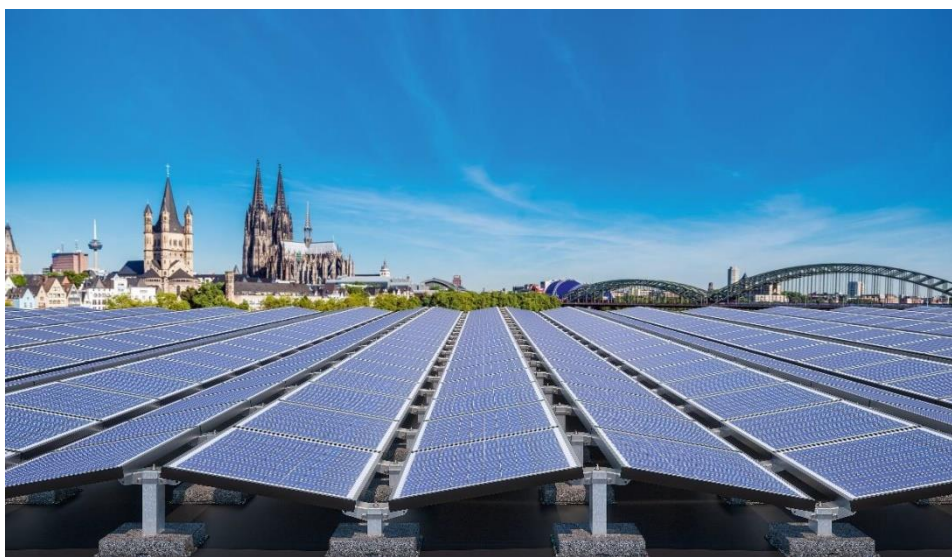
Abbildung 5: Beispiel: PV Ost-West-ausgerichtet
