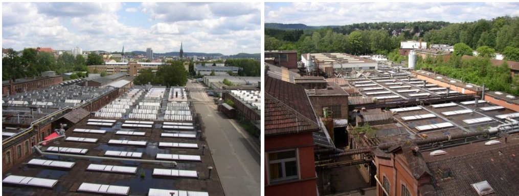
Fotos: Vogelperspektiven auf die Dachlandschaft des „Pfaffgeländes“
