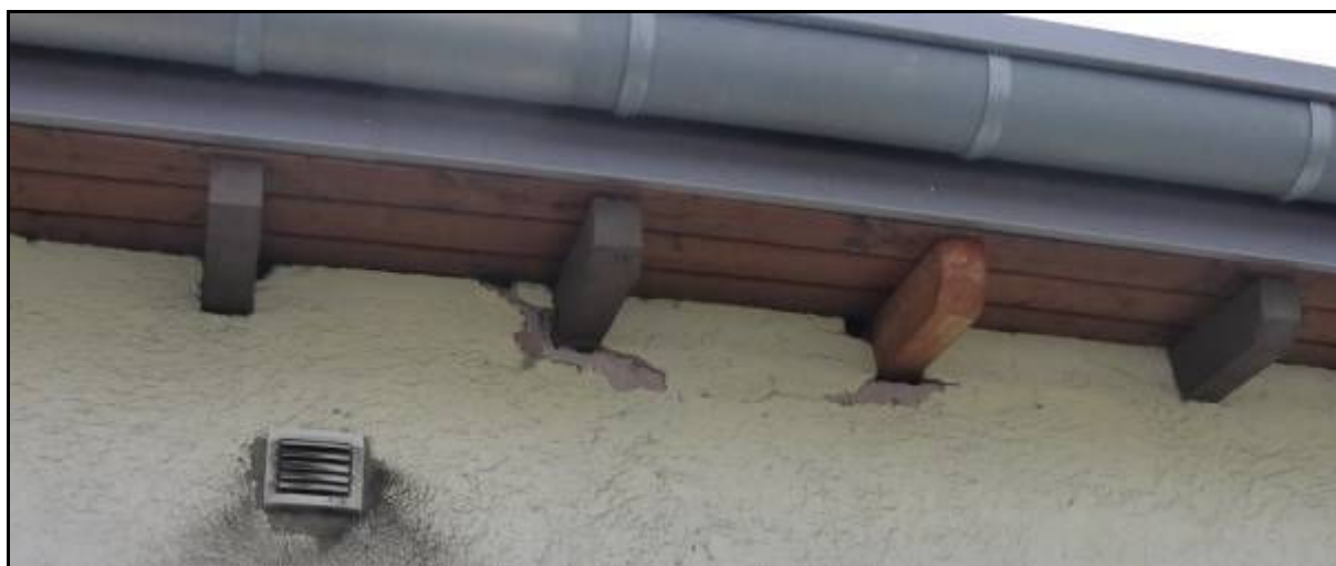
Abb. 6: Sicht auf das Mauerwerk im Bereich der Dachtraufe eines Gebäudes
